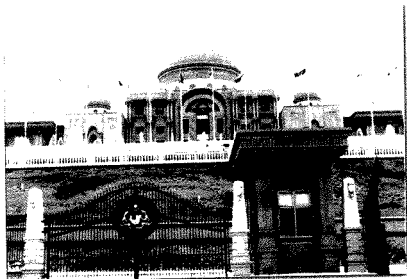
Kompleks Jabatan Perdana Menteri di Putrajaya.
